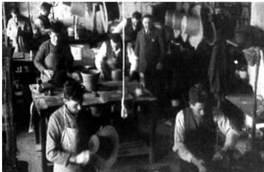
Mesas de sacos y planchadores.
