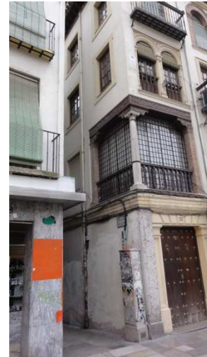
Edificio donde se ubicaba el Colegio de Santa Catalina. (Foto: E.A.O.)
