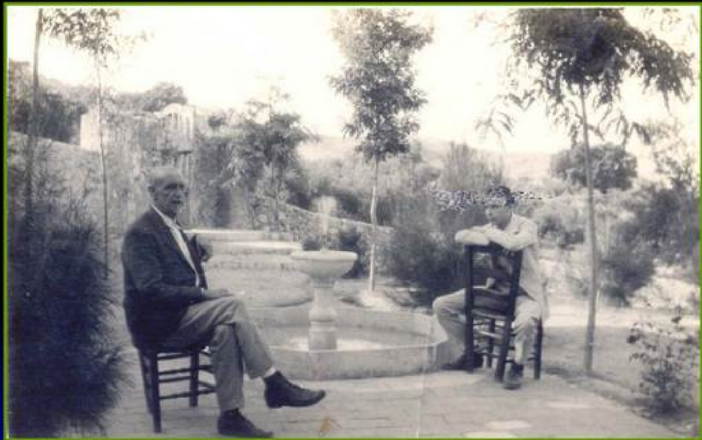
Descansando sobre sillas de enea, material entonces habitual.
