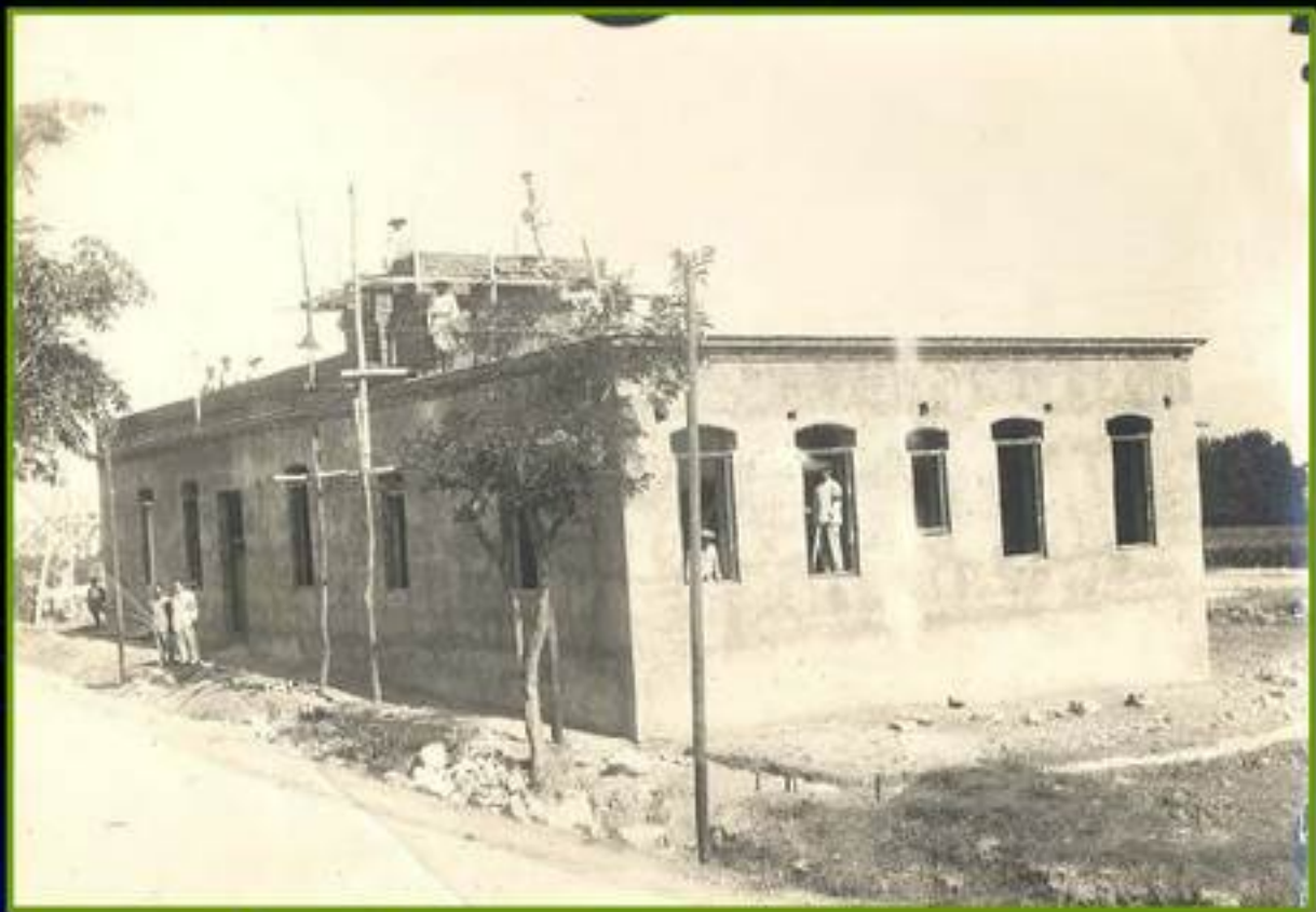
Construcción del colegio "Carlos Valverde", destinado a casa cuartel de la Guardia Civil.
