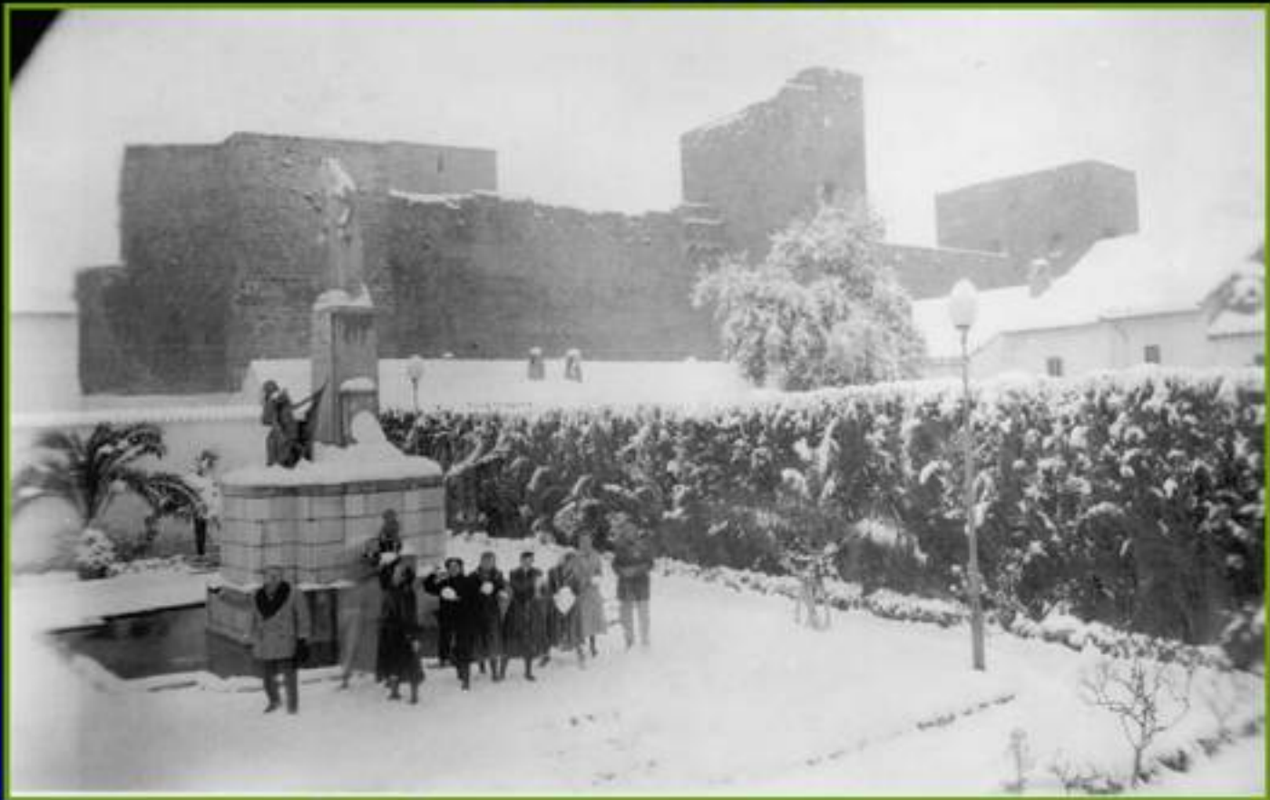
Nevada en el Corazón de Jesús. A la derecha las desaparecidas edificaciones. Al fondo, el Castillo.
