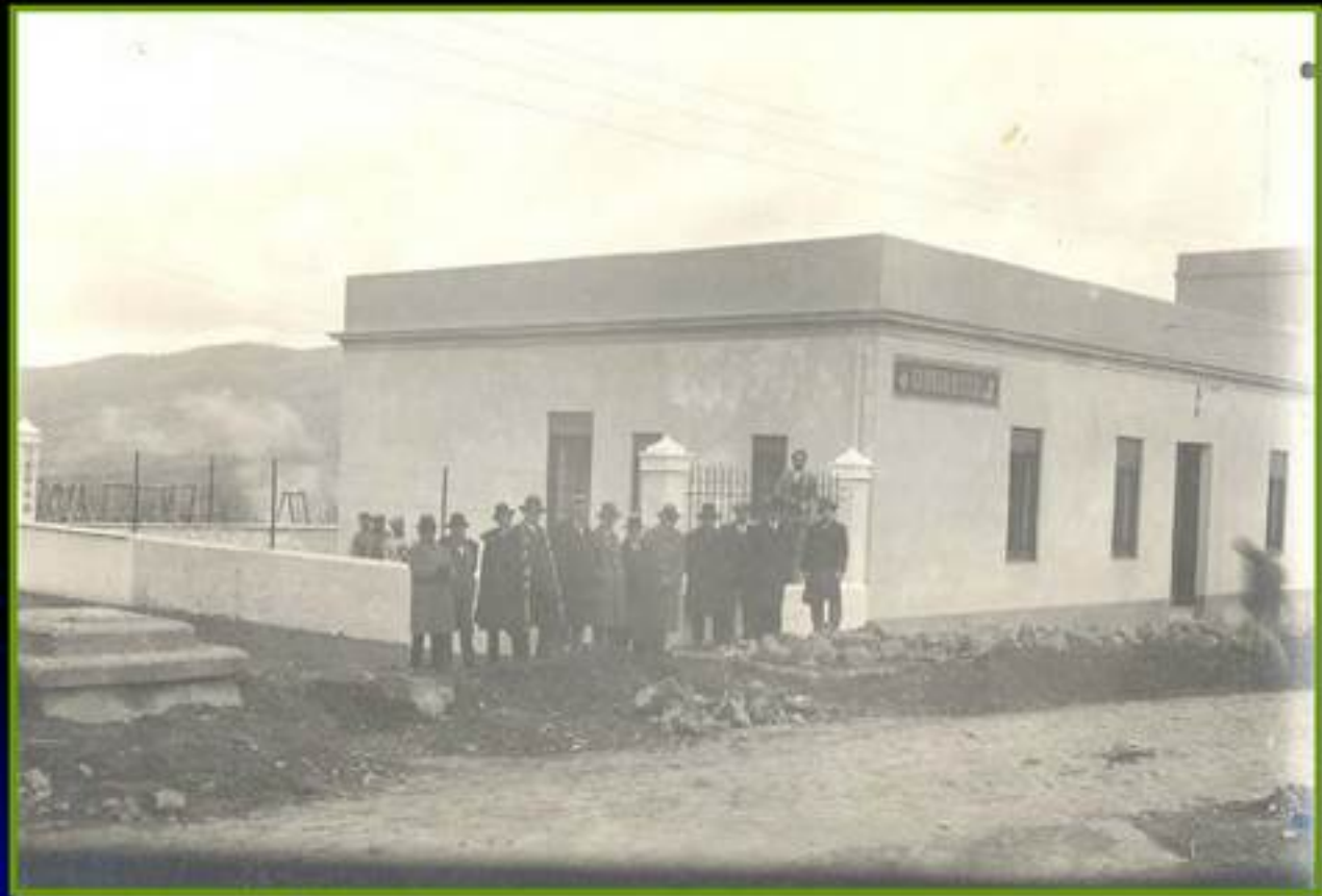
El recién construido edificio de la Subbrigada Sanitaria en el año 1930.
