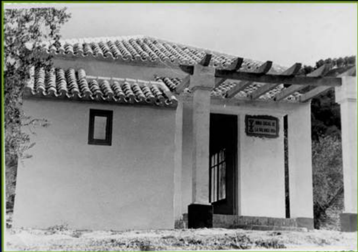
Edificio escolar de la "Obra Social de la Falange" en un diseminado de Priego. Por la década de los sesenta.
