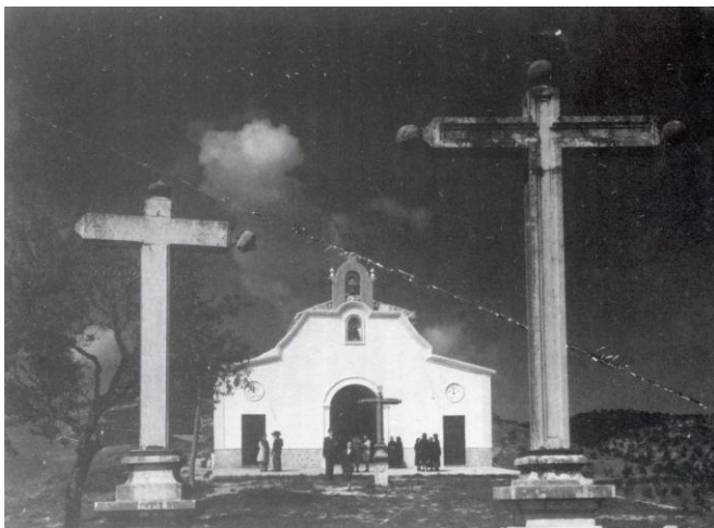
La ermita del Calvario levantada en el año 1939 por la cofradía de Nuestra Señora de los Dolores, bajo el mandato de D. Julio Matilla Pérez.
