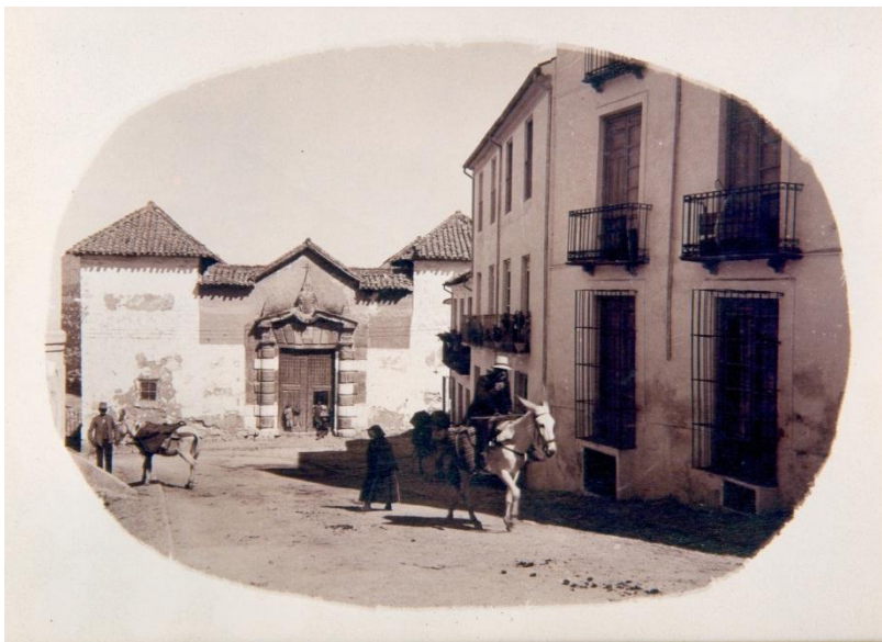
Carnicerías municipales. Edificio del siglo XVI.
