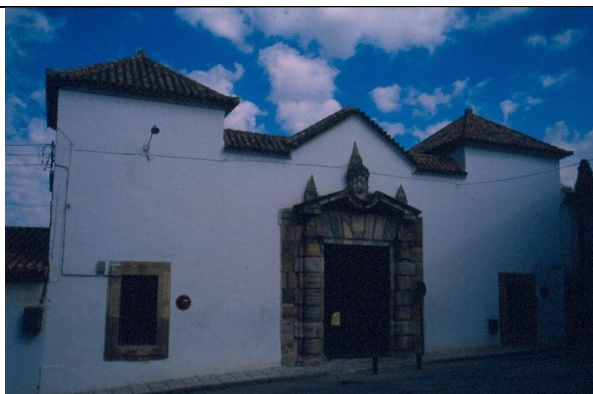
Fachada de las Carnicerías Municipales.
