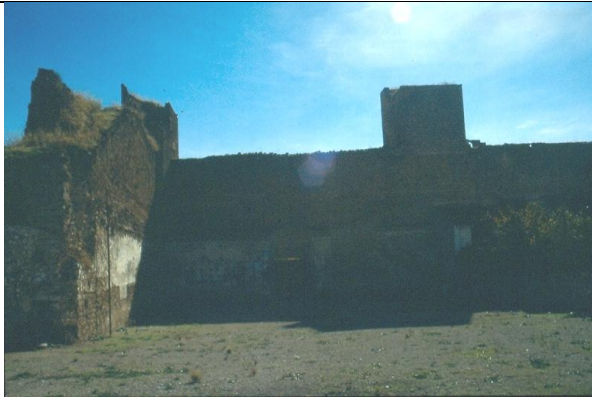
Patio interior del Castillo.
