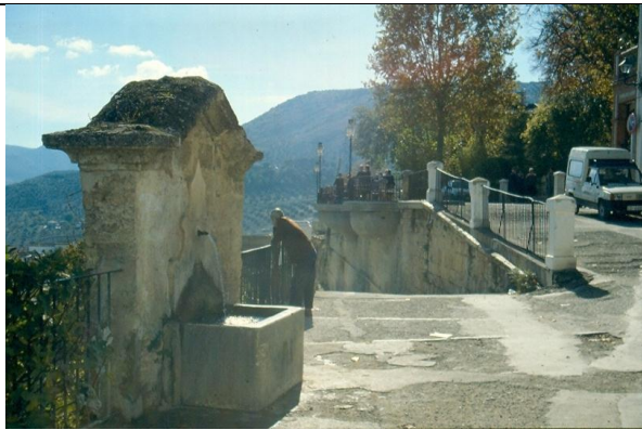
Fuente de la Puerta del Sol en el Paseo del Adarve.
