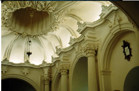
Muros, columnas, cornisas y cúpula de la antigua sacristía, hoy adoptada al culto, de Nuestra Señora del Carmen.
